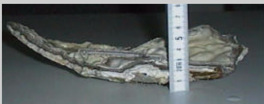
Inkrustation am Boden des Rohres
