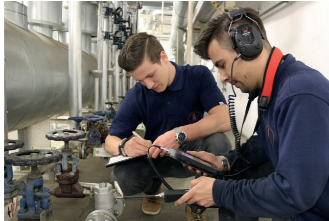
Für ihr Projekt „Kondensatableiter als wichtiger Baustein der Energieeffizienz“ wurden die Azubis Franz Weber (links) und Martin Becher (rechts) der Peniger Papierfabrik ausgezeichnet.
