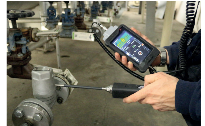
Aufnahme des Ultraschallsignals im Frequenzbereich von 20 bis 100 Kilohertz mit dem breitbandigen Körperschallsensor. Die Geräuschcharakteristik von defekten Kondensatableitern unterscheidet sich auf den ersten Blick von der Charakteristik intakter Ableiter.
